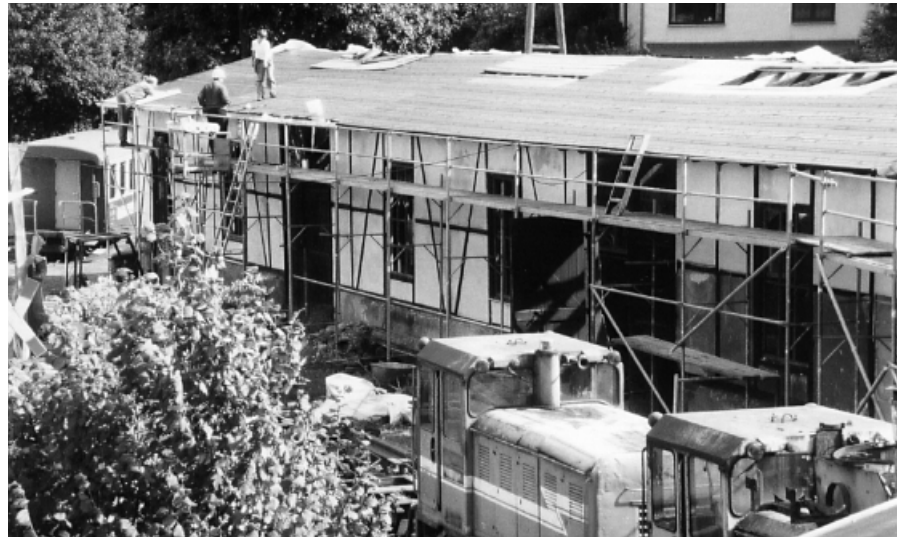
Weitgehend renovierter Gebäudebereich in Brohl
