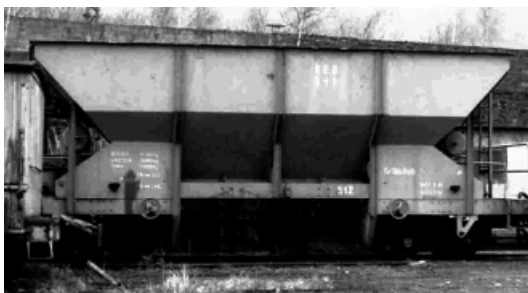
Wagen 512 entspricht dem Original ohne Abdeckung mit Blattfederung (Foto: P. Middelhauve)
